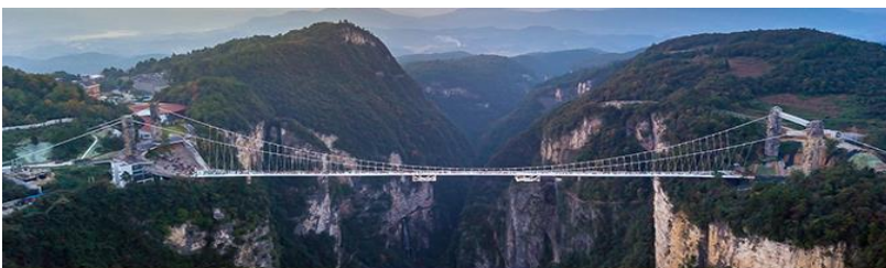
สะพานกระจากวางเจียเจี๋ย
