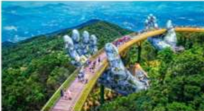
สะพานลอยฟ้า Golden Bridge
