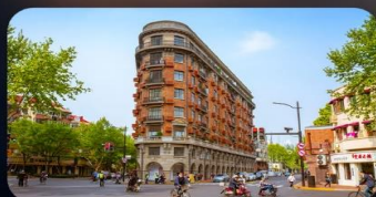
อาคารร้อยปีอูตง
