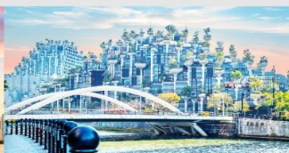
อาคารฟันทันไม้
