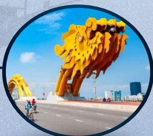
สะพานมังกร (Dragon Bridge)
